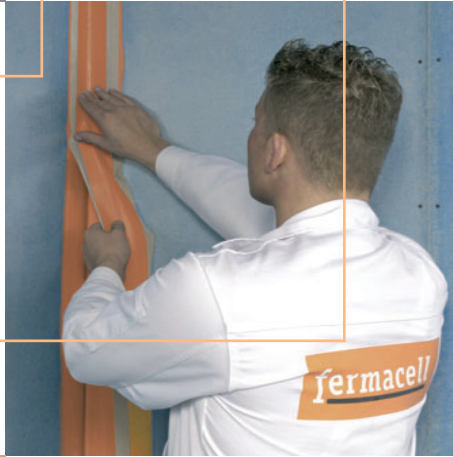
Figure 2 : Presser la bande d'étanchéité FERMACELL dans le lit d'étanchéité encore liquide et, en un 2 ème passage, la recouvrir d'étanchéité liquide
