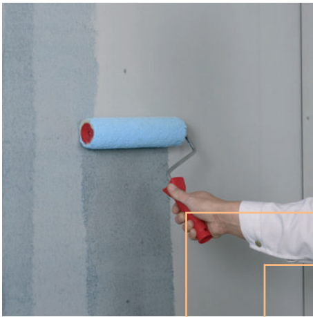
Figure 1 : Appliquer le primaire FERMACELL
