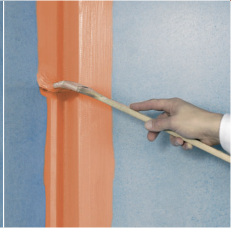
Figure 2 : Presser la bande d'étanchéité FERMACELL dans le lit d'étanchéité encore liquide et, en un 2 ème passage, la recouvrir d'étanchéité liquide
